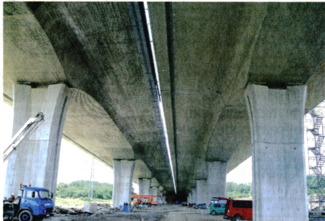
ESTAKÁDY. V úseku mezi Lipníkem nad Bečvou a Bělotiněm se nacházejí také dvě mostní estakády, jedna je dlouhá 400 a druhá 500 metrů. Foto: Naďa Jandová
