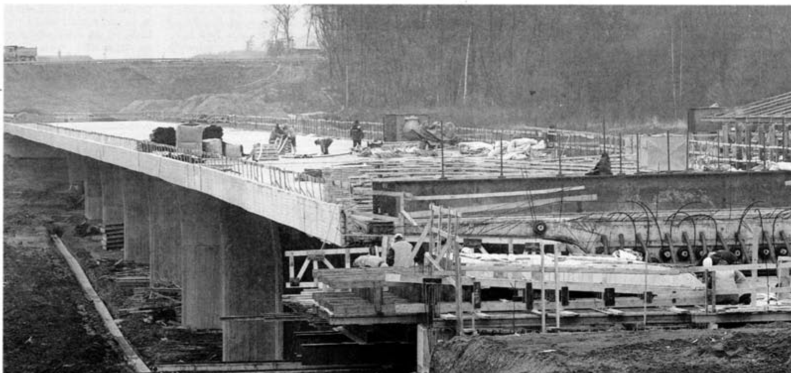
STAVBA. Práce na stavbě patnáctikilometrového úseku dálnice mezi Lipníkem nad Bečvou a Běloučkem jdou do finále. Foto: Martin Trškal
